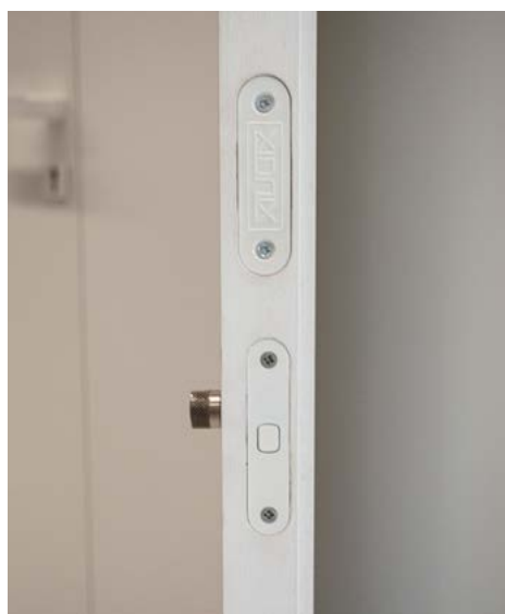
NZ magneetrolslot + zwenkslot
